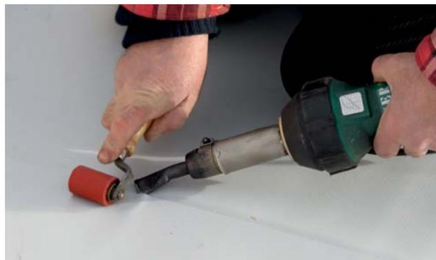
Appareil manuel servant à souder des matériaux thermoplastiques pour les poseurs de bandes d'étanchéité, les poseurs de bâches, les poseurs de planchers, les personnes traitant le plastique, etc.
